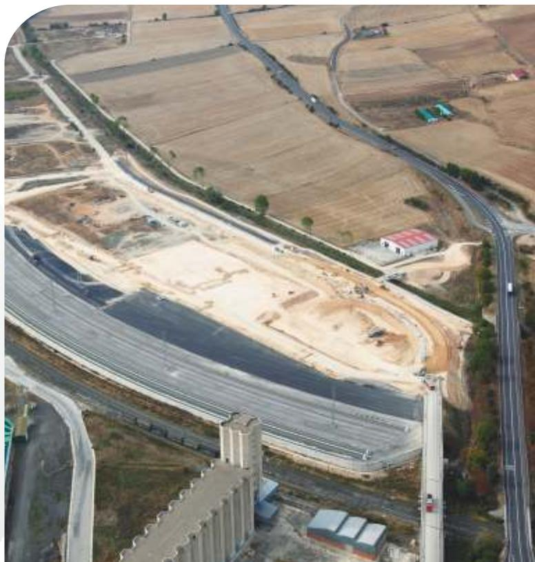
La terminal cuenta ya con conexión ferroviaria y vías de servicio. Dispone, en concreto, de una vía de expedición y recepción de trenes de 750 metros, dos vías de carga y descarga de 600 y 650 metros y una vía mango de 600 metros. El ancho de las vías es ibérico, con posibilidad de migración a ancho internacional.
